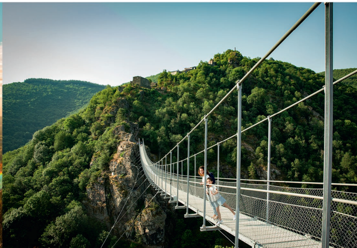
LA PASSERELLE DE MAZAMET
